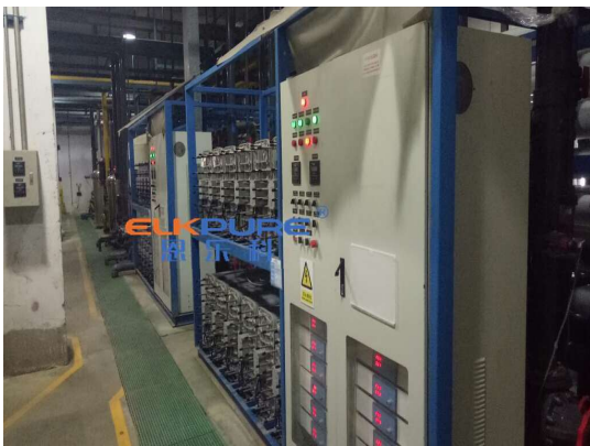
某大型光伏厂 24 台 IONPURE LXM45Z 维修现场
