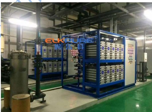
某大型多晶硅企业 20 台 GE E-CELL 3X 维修现场
