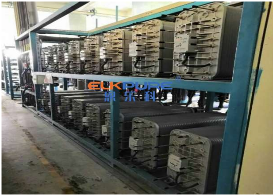
某大型电厂 40 台 IONPURE LXM45Z 维修现场
