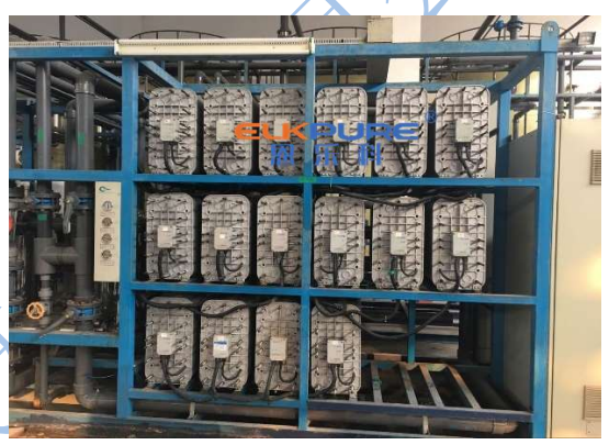
某大型电厂 36 台 IONPURE LXM30Z 维修现场
